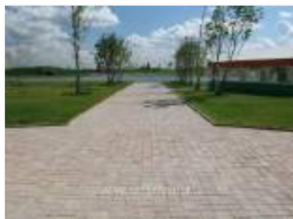
Укладка различных видов покрытия
